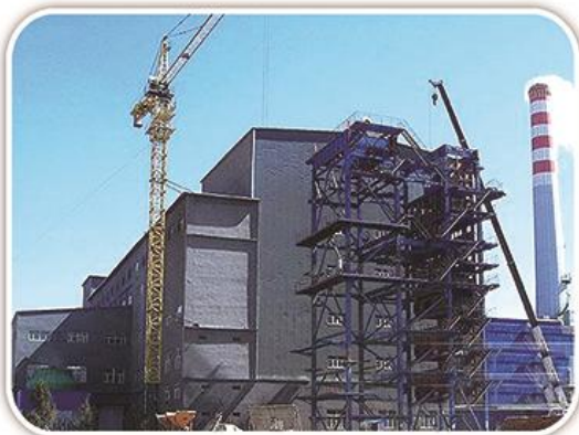
项目名称：海螺水泥沙河锅炉框架 项目地址：河北省邢台市沙河市 结构类型：钢框架结构
